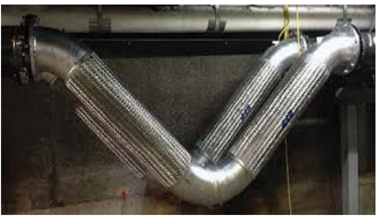
Fig. 4: V型配管實例。
